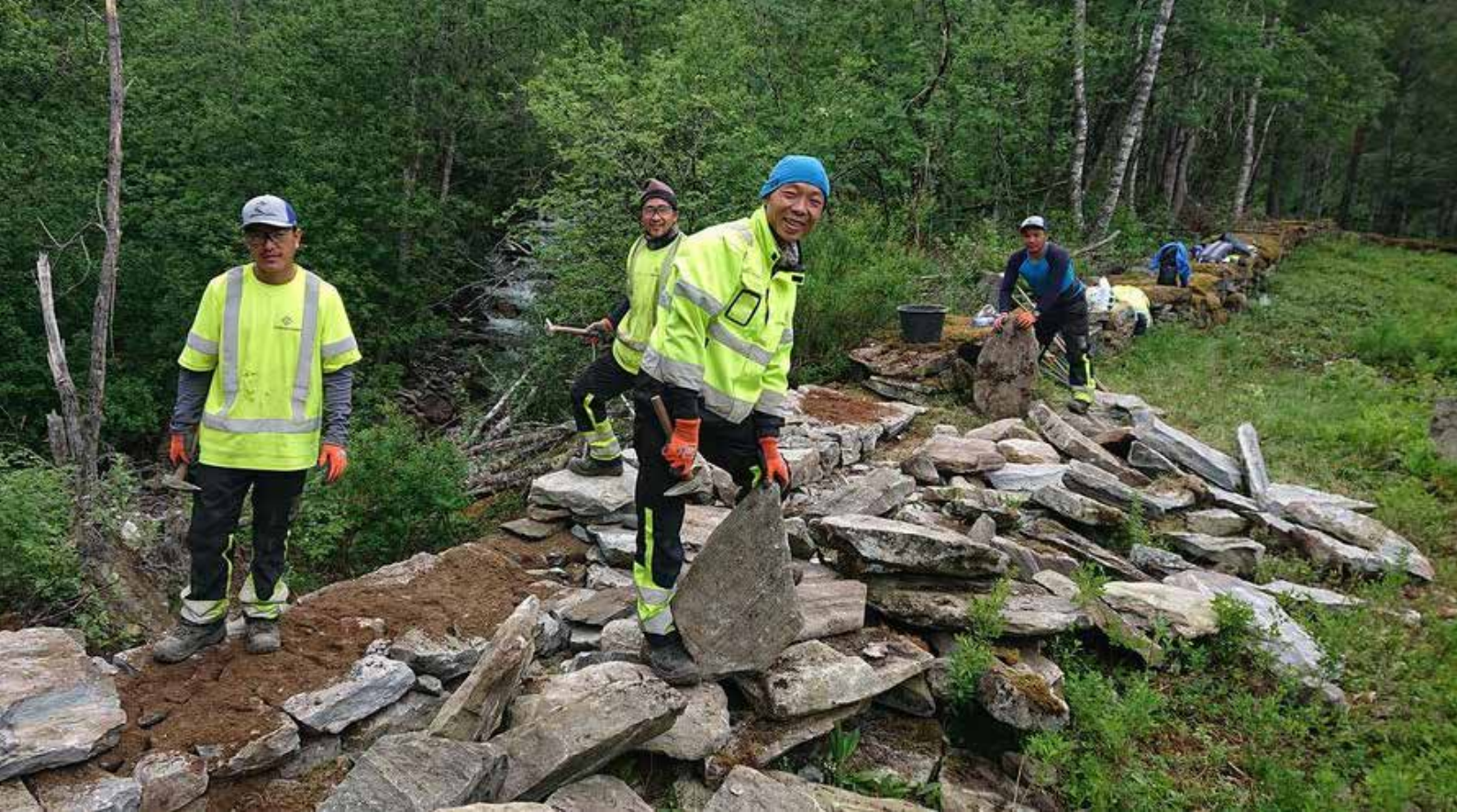
Sherpaer i arbeid med restaureringa av kyrkjegardsmuren.
